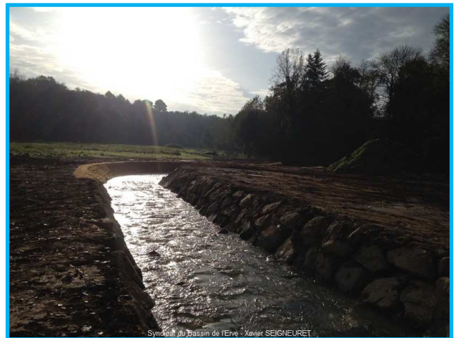
Travaux d'aménagement de l'Erve à VOUTRE : Dérivation du lit et passe à poissons rustique
