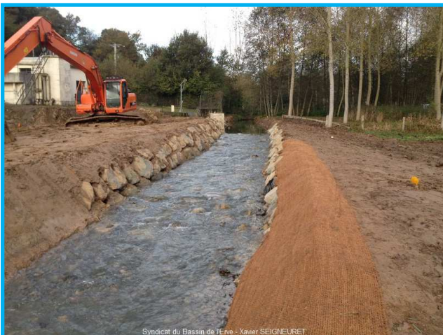
Travaux d'aménagement de l'Erve à VOUTRE : Dérivation du lit et passe à poissons rustique
