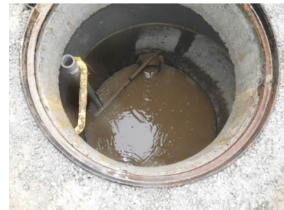
Photos de l'installation
