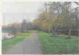
La digue va être totalement refaite.
