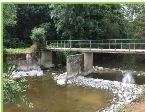
Suppression de l'ouvrage Recharge du radier
