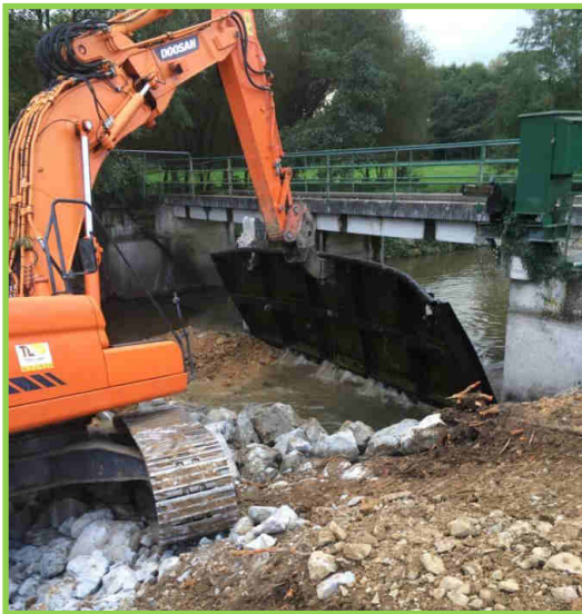
Suppression du barrage
