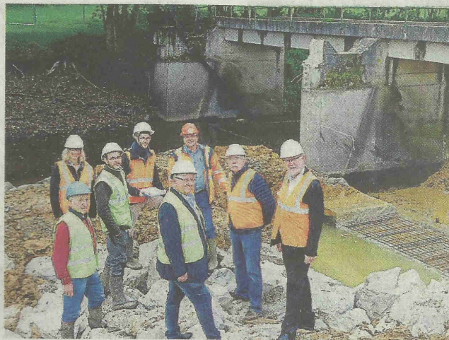
Les représentants du Syndicat de Bassin de la Jouanne ont présenté l'avancée des travaux du plan d'eau aux élus locaux. Ici devant le radier où pourront dorénavant passer les poissons.
